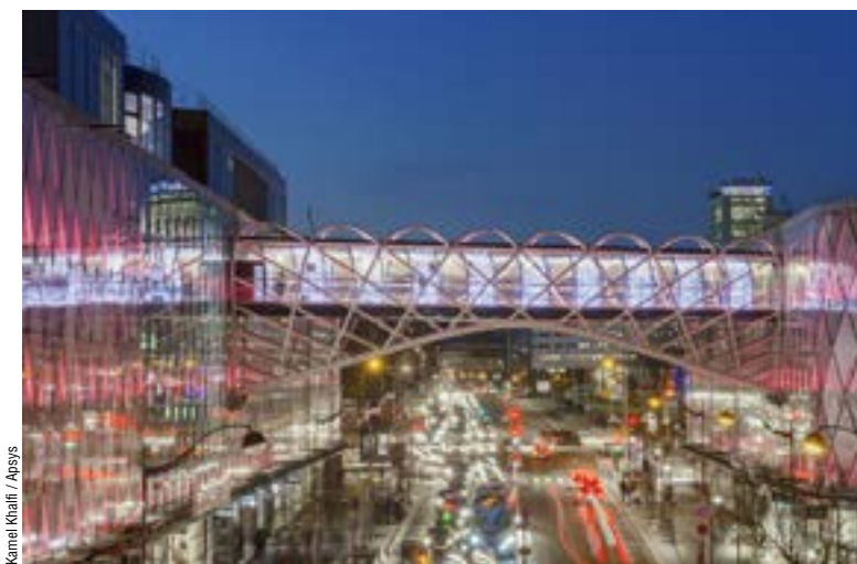
La restructuration du centre Beaugrenelle, en 2013 par Valode & Pistre pour Apsys, a eu une incidence sur l'entrée du quartier Front de Seine (Paris XV*).
