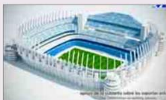
Secuencia de las distintas fases de la remodelación del estadio, desde la colocación de la nueva cubierta hasta el despliegue de la piel de titanio que cubrirá todo el edificio.
