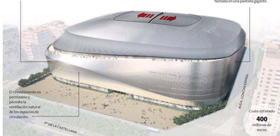
De noche, un sistema de iluminación por LED dotará a la fachada de una luz suave y cambiante, tanto en color como en intensidad, que emana del interior.
