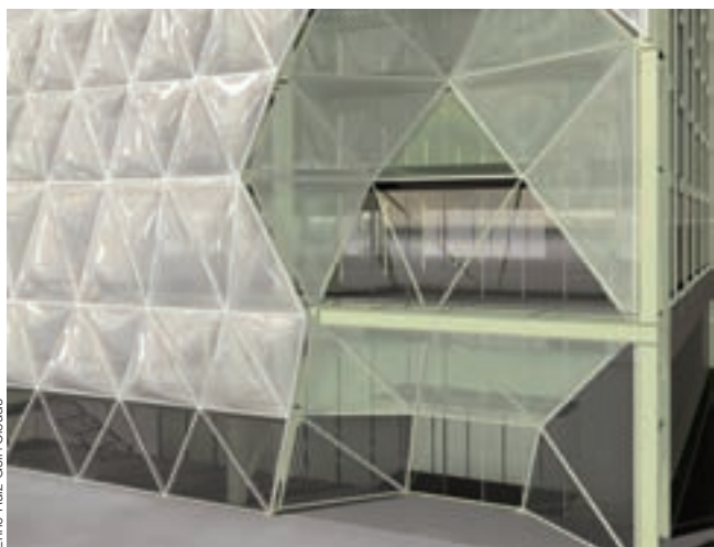
La piel de Etfé está compuesta de inflables que disponen de hasta tres cámaras de aire. Esto no sólo mejora el aislante térmico, sino que también permite la creación de sombra a través de un sistema neumático.
