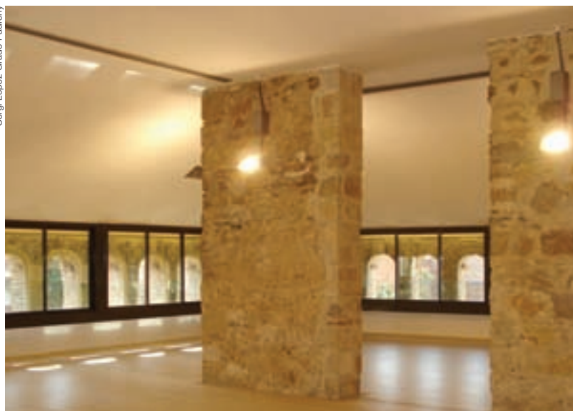
El proyecto cuenta con ventanas colectoras desarrolladas en dos elementos dispuestos horizontalmente, conformada por elementos estandarizados de carpintería de aluminio con módulos deslizados dotados de paneles acristalados con doble luna y cámara seca.
