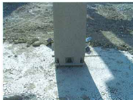
La conexión de los pilares prefabricados a cimentación directa se ha realizado con zapata aislada y con pilotaje con encepado
