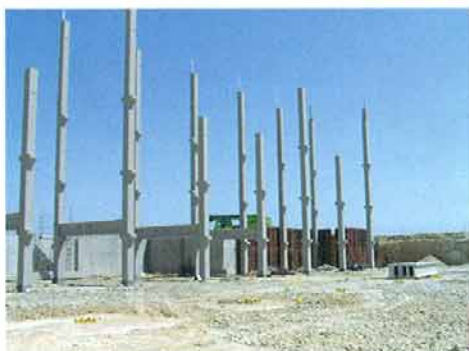
La conexión de los pilares prefabricados a cimentación directa se ha realizado con zapata aislada y con pilotaje con encepado
