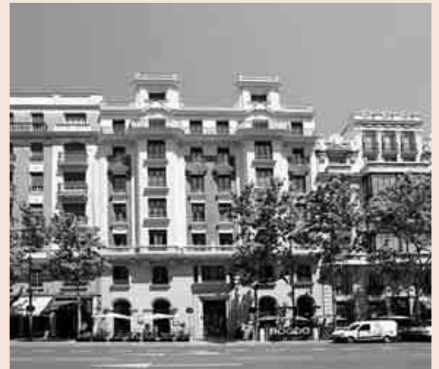
Edificio de la calle Velázquez donde están las viviendas.
